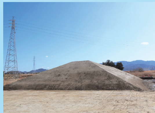
部分的に完成した築堤盛土の状況
