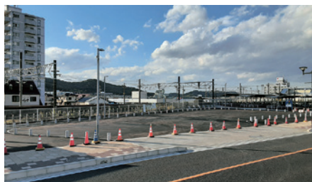
←ロータリー出入口 付近からの写真 (工事中)
