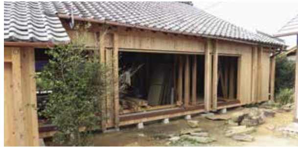
改築中の古民家（荻）
