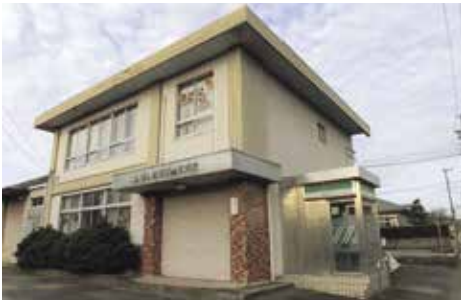
多文化共生施設などに改修（野場）
